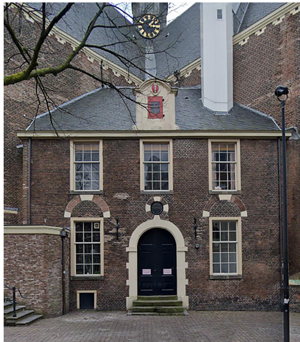
▲◀ De hiervoor beschreven aanpassing van kruisvensters zien we bijvoorbeeld terug in de Noorderkerk (1623); de prent van Fouquet - naar een tekening van Herman Schouten - laat kruisvensters zien die op enig moment gewijzigd blijken te zijn in kozijnen met schuiframen / Google StreetView
