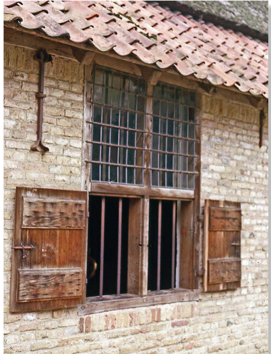
▲ Klassiek houten kruiskozijn, onder open met luiken en diefijzers, boven glas-in-lood met verstevigingsroeden; voor zo'n venster moeten we tegenwoordig al naar een openluchtmuseum
