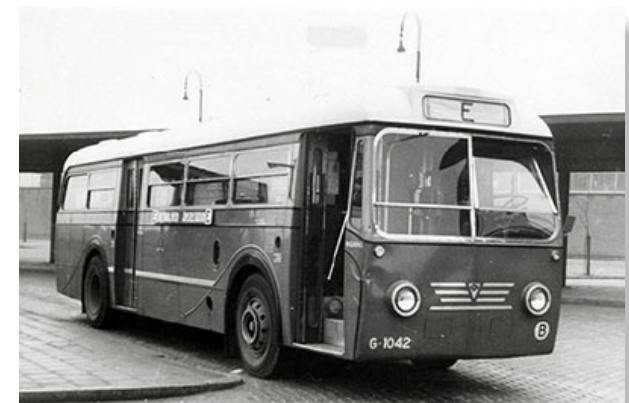
Hieronder de AEC proefbus die de GVB eind 1950 twee maanden op proef kreeg, met een nieuwtje... een lijnfilmkast (Foto: GVB)
