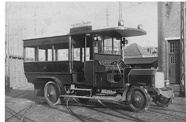
De eerste stadsbus van de GTA in 1908 op lijn 14 van de Dam naar de Van Hallstraat bij de Haarlemmerweg. Op een FIAT vrachtwagenchassis was een oude paardentram gemonteerd. (Foto: SAA)
