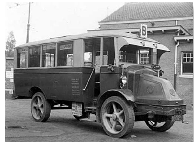
In 1924 kwamen deze Latil-bussen op lijn B (Meteorensingel) in bedrijf. De hoge vloer was nodig om bij extreme waterstanden in het IJ niet vast te lopen op de pontklep (Foto: GVB)
