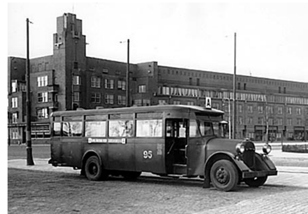
In 1928 kwamen twee series grotere bussen op een autobus-chassis in bedrijf. Boven een Brockway chassis met Werkspoor opbouw en benzinemotor (Foto: GVB)
