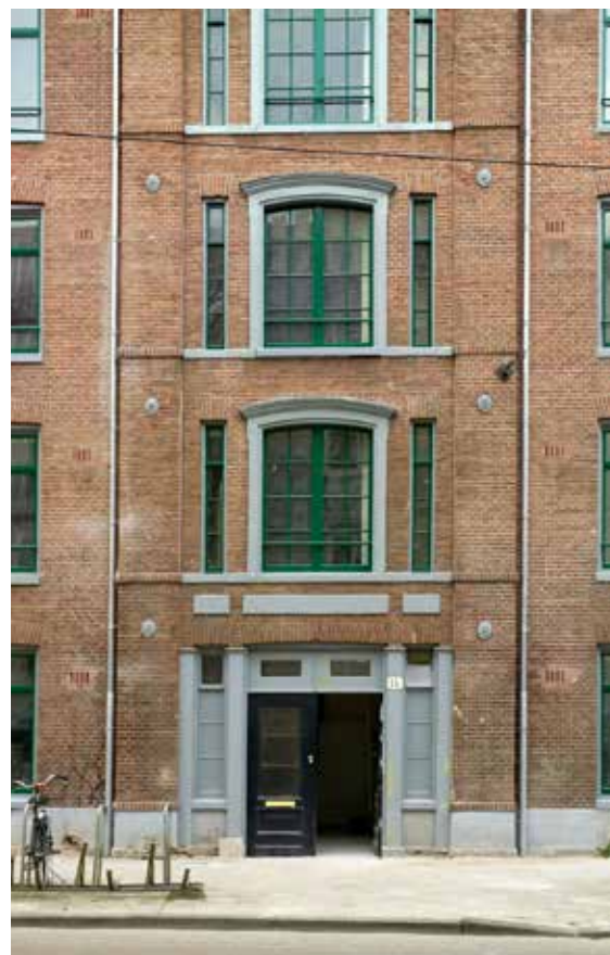
Links: Ingangspartij Planciusstraat 16 na de renovatie
