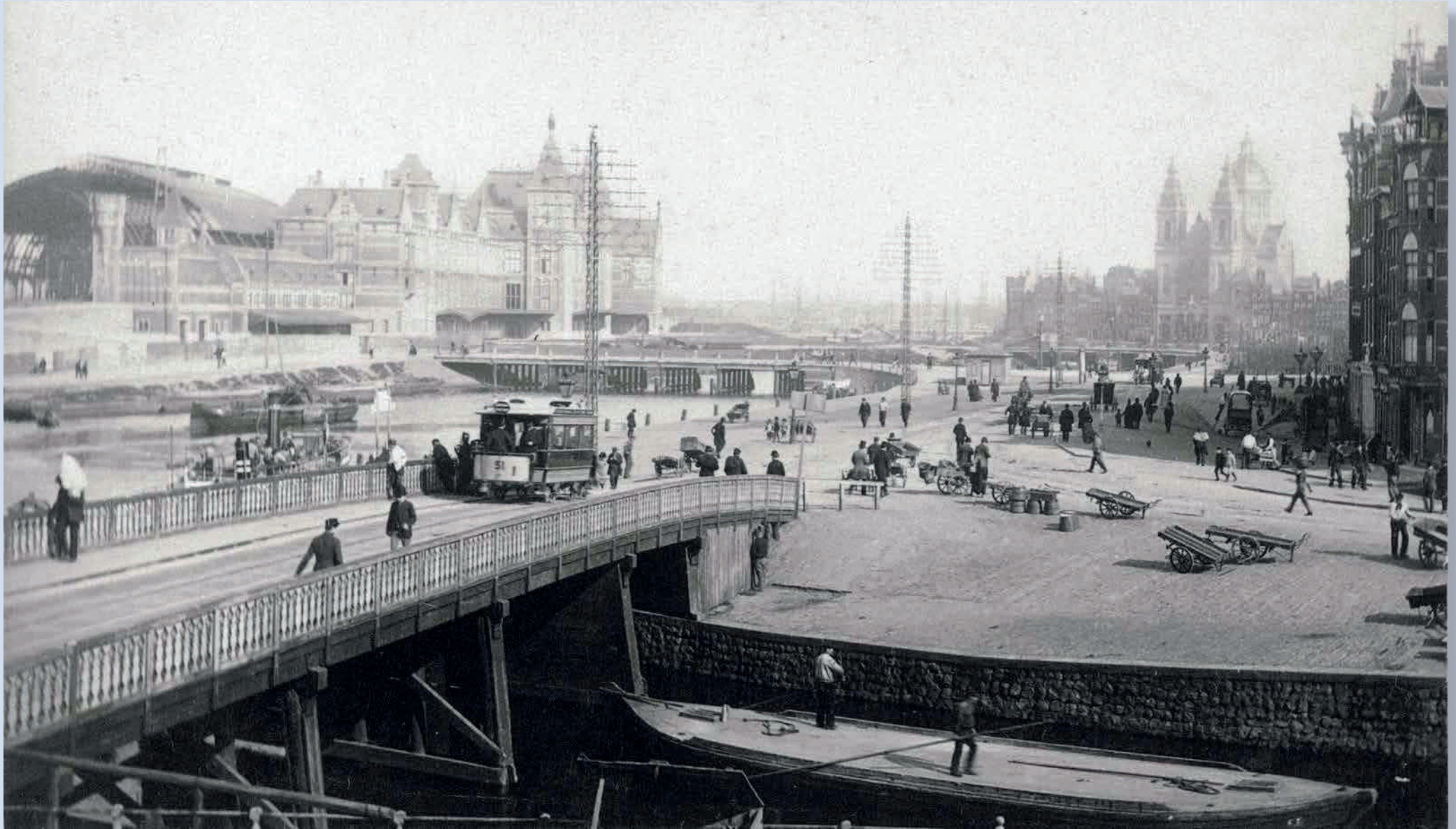
De Haringpakkersbrug (brug nr. 58) in 1887, hier nog als noodbrug voor de paardentram naar het HIJSM-station. De brug verdween weer toen het Centraal Station geopend werd maar begin jaren '70 kwam ze weer terug om de nieuwe autoroute van Prins Hendrikkade naar de Haarlemmer Houttuinen te ontsluiten.
