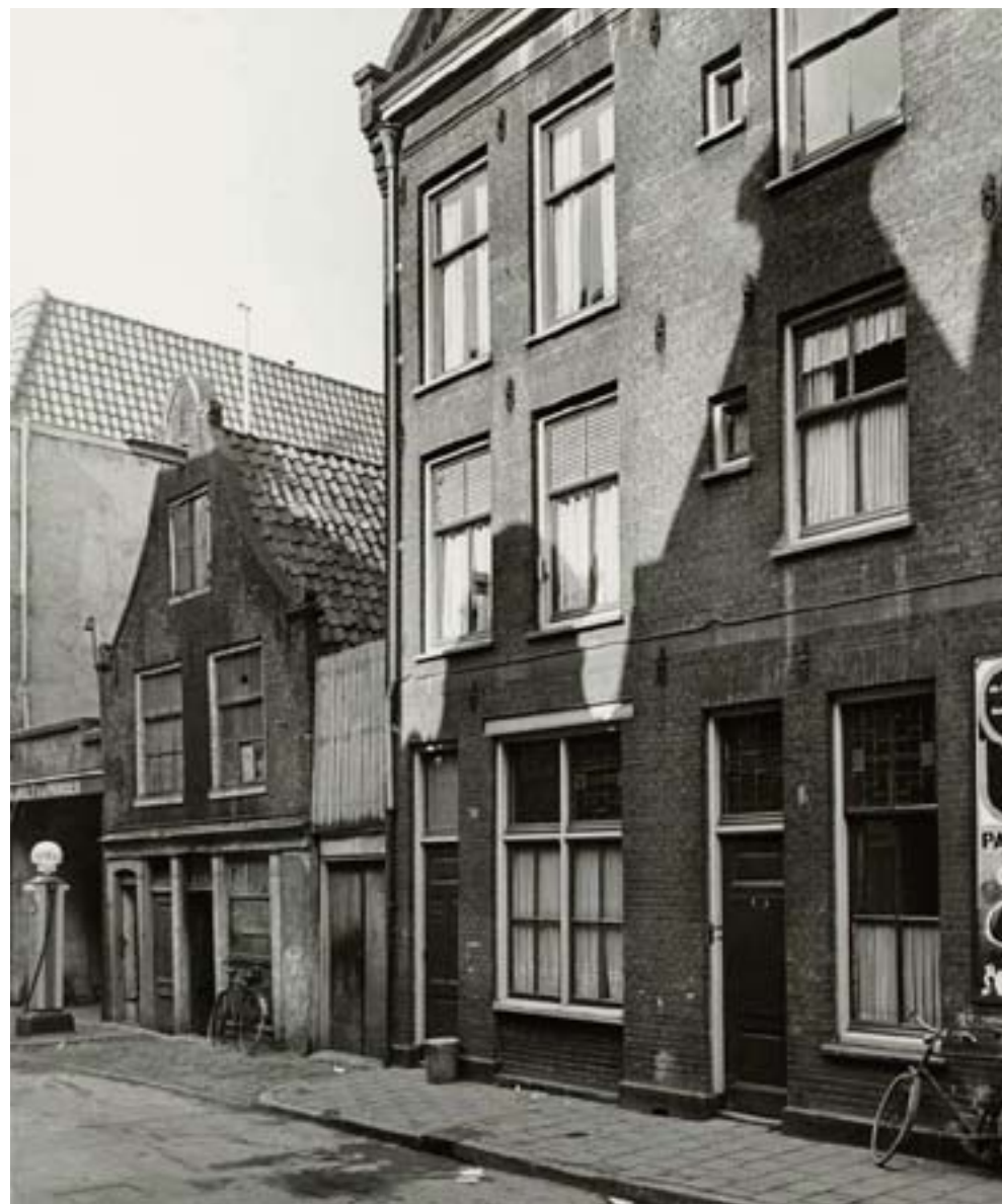
Boven: Twee gangen in de Oude Looiersstraat; rechts naast de benzinepomp de toegang tot de Naaldenmakersgang en rechts van perceel 54 de Bontekoe's-gang.
