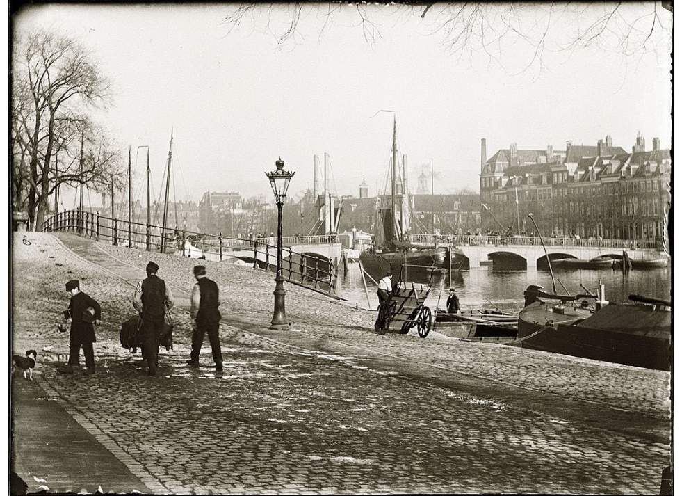
'Magere Brug' over de Amstel; 1894.
