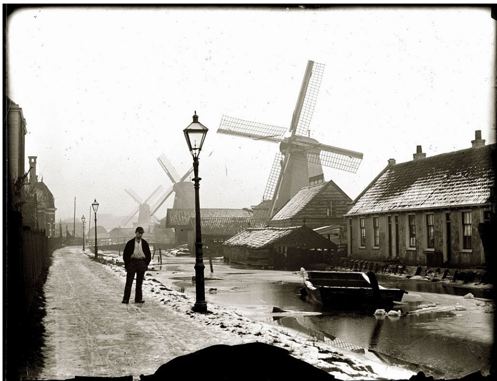
De Middenweg in de Zaagmolenbuurt (tegenwoordig Gillis van Ledenberchstraat); vóór 1896.
