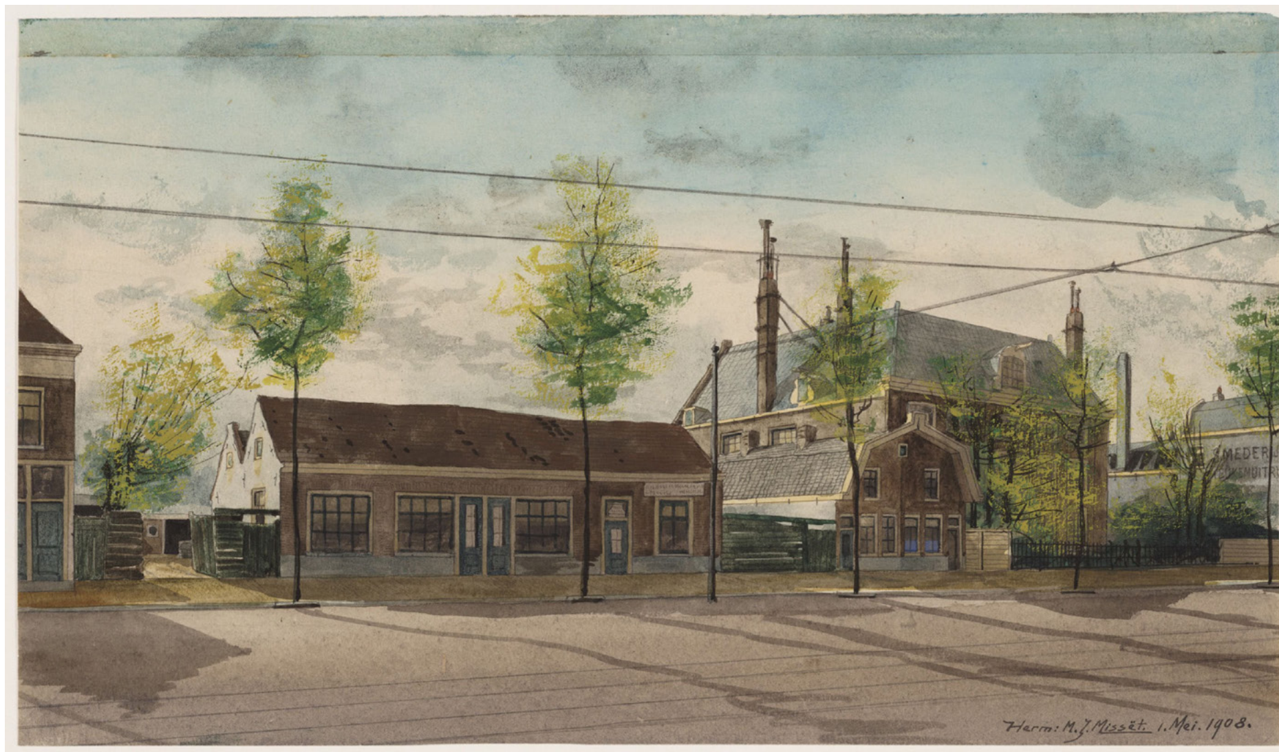
1908 - Overtoom met rechts het gesticht "Eendracht" (Overtoom 295) ▲ De Eendracht werd gebouwd op de plek van de afgebrande Fransche Schouwburg en was afwisselend gesticht voor (arme) bejaarden en rusthuis.
