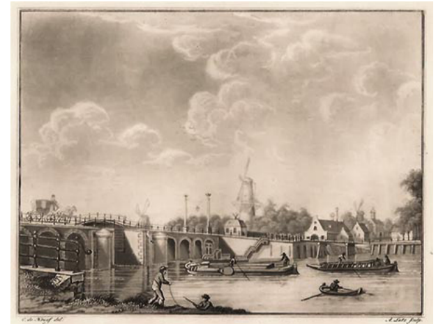
Van boven naar beneden: brug van 1662, daaronder brug met beweegbaar brugdek en onder de sloop.
