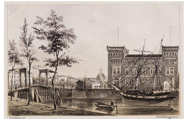
▼ De vaste Kortjewantsbrug met oorgat werd vervangen door een dubbele ophaalbrug
