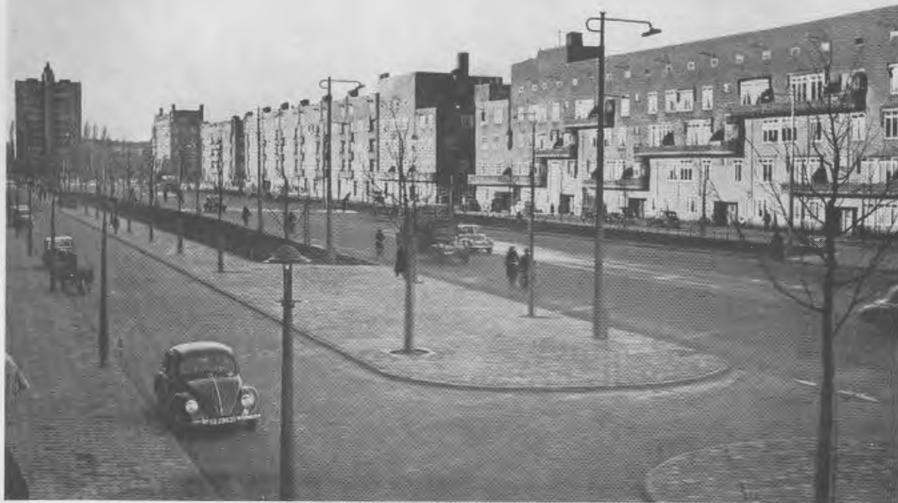
Stalinlaan, voorbeeld van modern wegprofiel.
