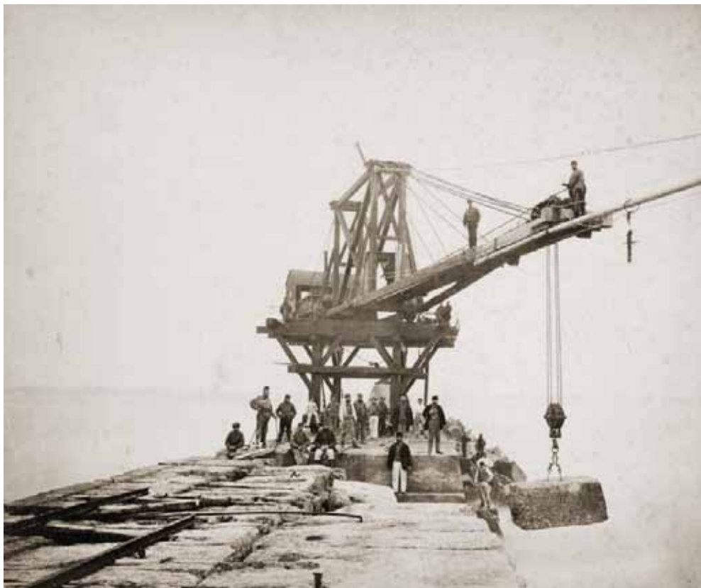
Boven de T-tankraan die bij het bouwen van de pieren ingezet werd.
