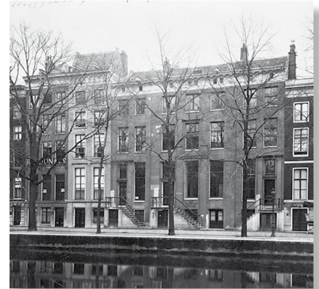
Boven: Keizersgracht 730-734 vóór de verbouwing van 1923 (SAA)
