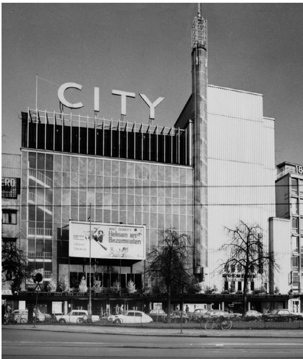
Boven: Het City Theater zoals het er in 1972 uitzag. Het gebouw heeft diverse gedaantewisselingen ondergaan en nu zijn er plannen om weer terug te keren naar het beeld van 1935 (zie foto volgende pagina).
