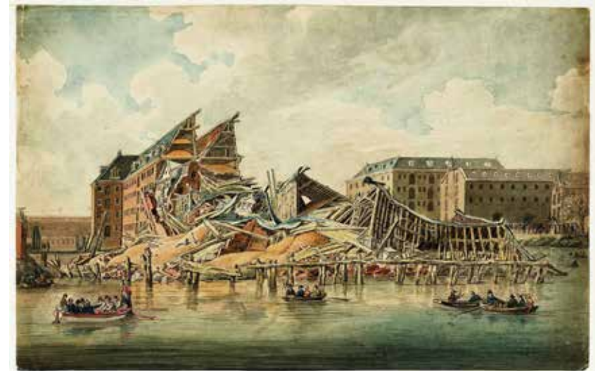
Fig. 6 - Het Oost-Indisch Zeemagazijn op Oostenburg na de instorting in 1822, gezien in zuidoostelijke richting. Rechts op de achtergrond het Nieuwe Magazijn. (Stadsarchief Amsterdam)
